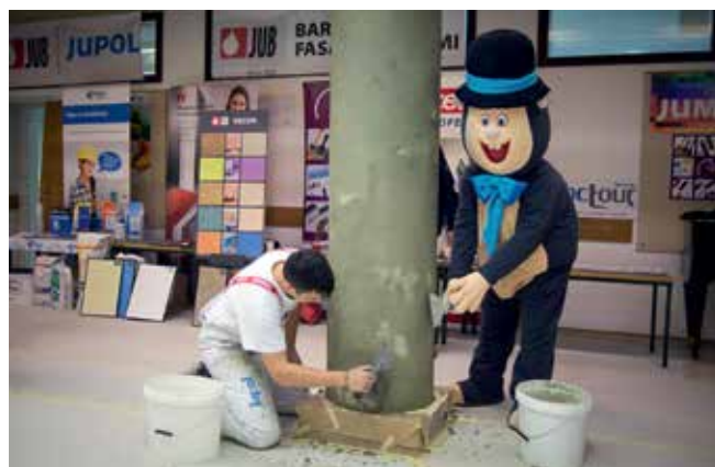
JUB-ov slikopleskar je podporne stebre v avli obdelal z dekorativno tehniko Beton Look
