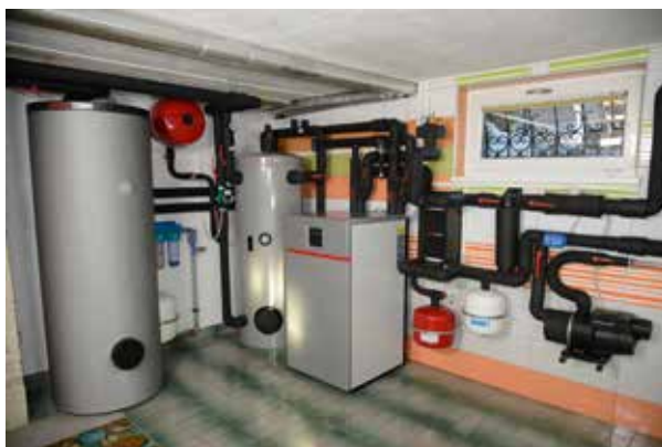
obnova ogrevalnega sistema s toplotno Geos
