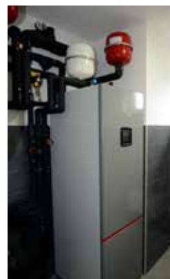
vgradnja Geosa v novogradnjo
