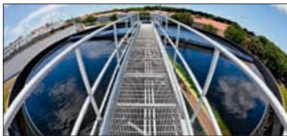
Slika 1: komunalna čistilna naprava Jesenice
