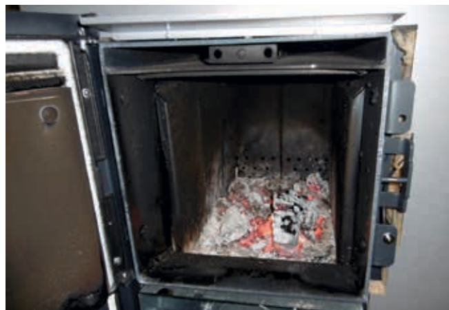
Vitoligno 150-S zgorevalna komora
