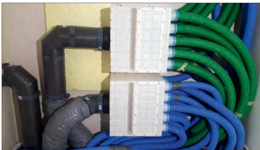
Primer izvedbe rekuperacijskega prezračevanja z uporabo razdelilcev Maincor
