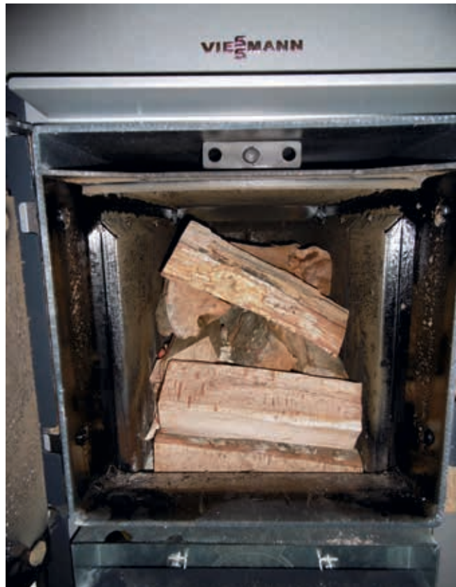
Vitoligno 150-S zgorevalna komora
