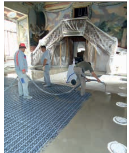
Prekrivanje MINITEC sistema s samorazlivnim estrihom
