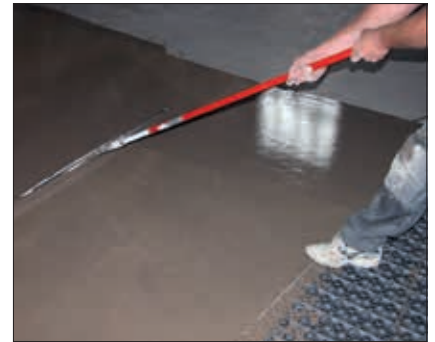
Prekrivanje MINITEC sistema s samorazlivnim estrihom
