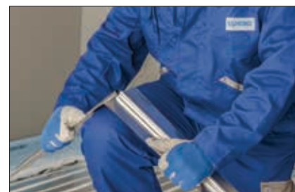
Razdelitev plošče za prenos toplote z enostavnim krivljenjem
