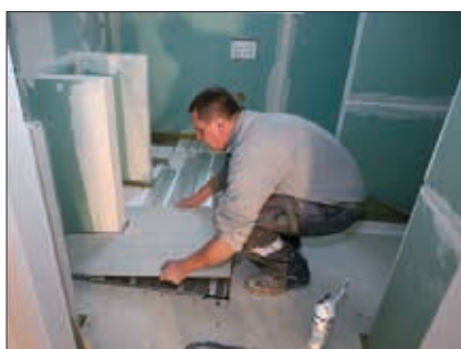
Hitro prekrivanje sistema talnega ogrevanja s ploščami Knauf Brio (foto: BerndDücke)
