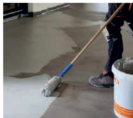
Nanos tesnilne mase PCI Seccoral 1K
