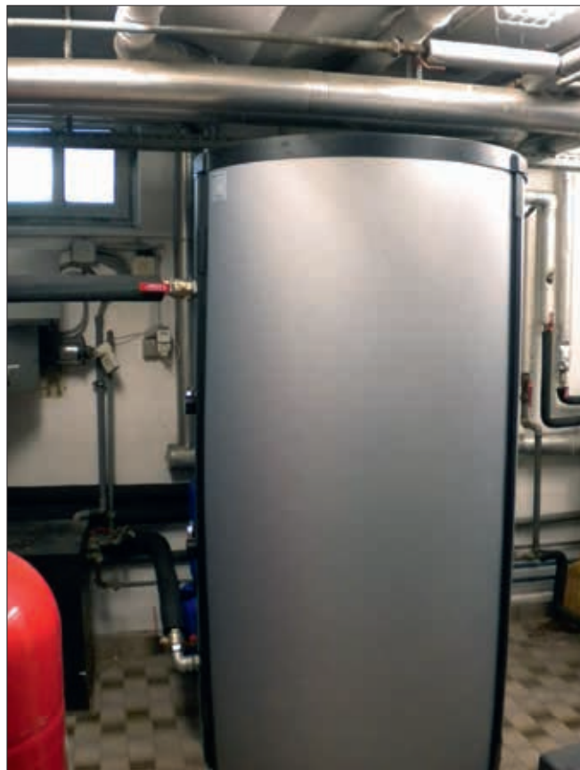
Slika 3: Hranilnik ogrevalne vode V=1.500\text{L}
