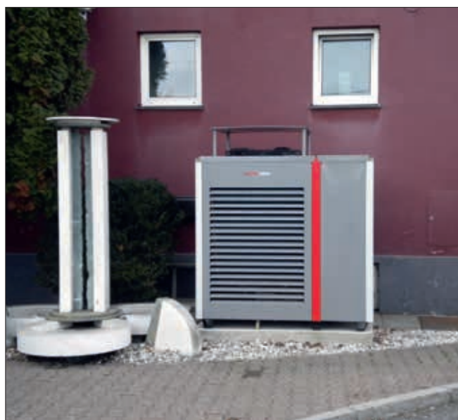
Slika 2: Toplotna črpalka za ogrevanje KRONOTERM WPL-45-KT HT
