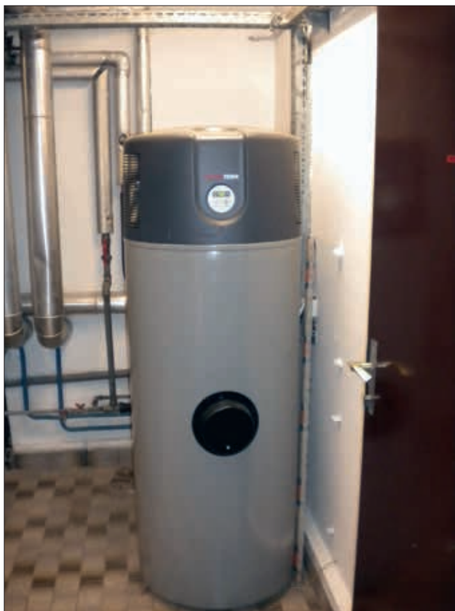
Slika 1: Sanitarna toplotna črpalka KRONOTERM WP2-3001E
