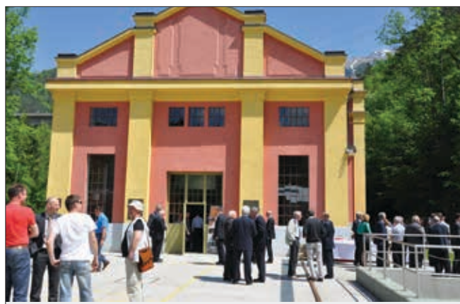
Arhitekturno značilna stoletna stavba strojnice hidroelektrarne Završnica. Foto: dr. Drago Papler
