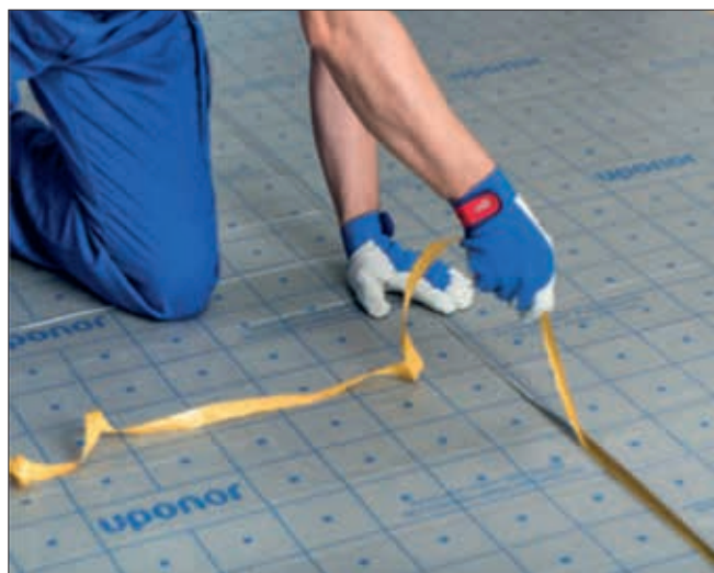
Samolepilni trak vzdolž plošče za hitro vodotesno povezovanje stikov plošč – samo odlepите varnostni trak in pritisnite teksturno folijo na podlago.
