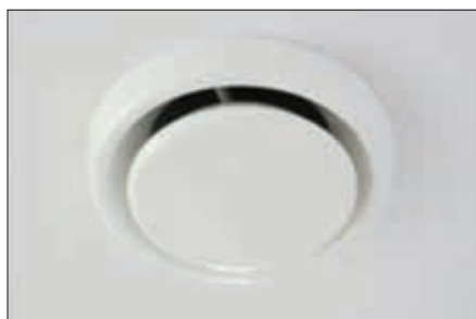
Slika 1: Prezračevalni ventili za izpih in zajem zraka (ventil na desni sliki je nameščen v kuhinji, saj ima lovilec maščob).
