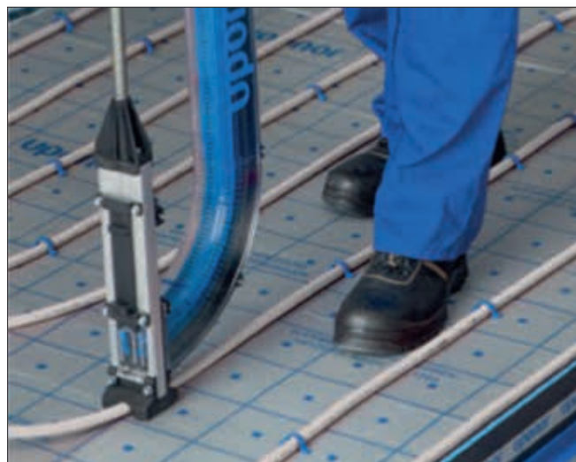
Hitra vgradnja cevi s pomočjo cevni pritrdilcev Uponor Tacker.
