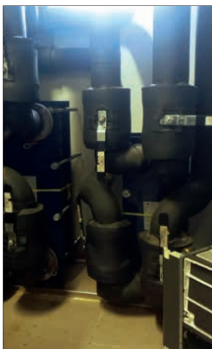
Medizmenjevalec -ogrevanje levo, medizmenjevalec – hlajenje desno
