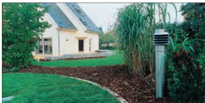
Slika 1: Pasivna hiša z zajemnim stebričkom za zračni zemeljski kolektor za potrebe prezračevanja z rekuperacijo.
