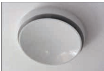
Slika 1: Prezračevalni ventili za izpih in zajem zraka (ventil na desni sliki je nameščen v kuhinji, saj ima lovilec maščob).
