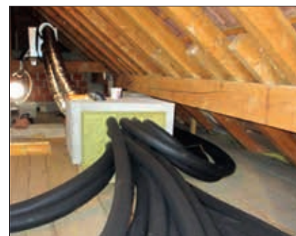
Slika 3: Razvod izoliranih prezračevalnih cevi, skupaj s prezračevalno napravo v ozadju.
