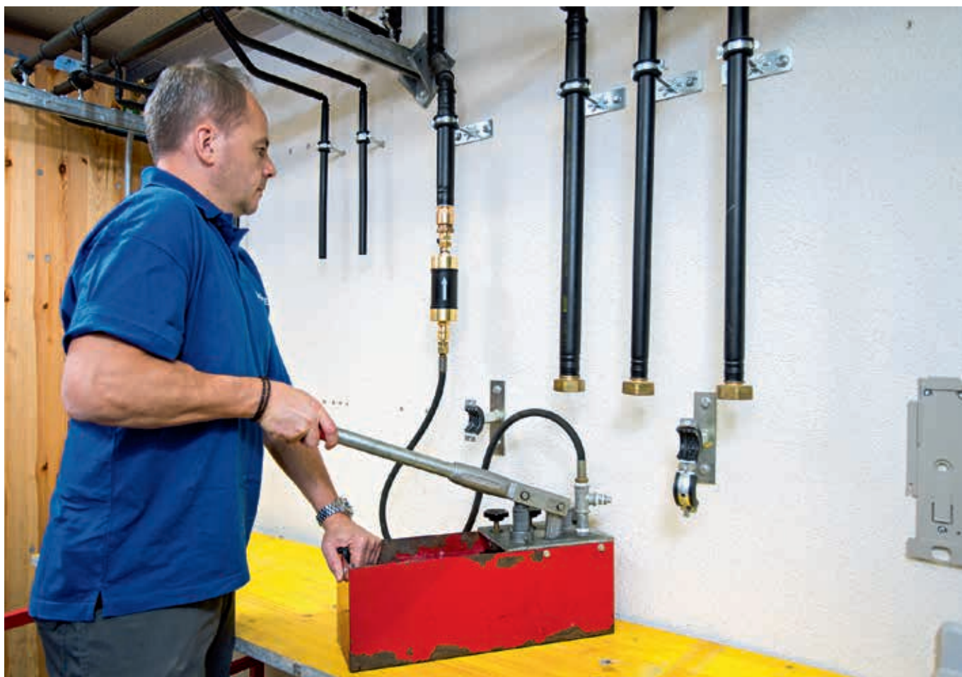
V cevem odseku, ki je že napolnjen z vodo, se s preizkuševalno črpalko ustvari nadtlak. Higienski filter preprečuje, da bi se nove cevi med tem postopkom onesnažile.
