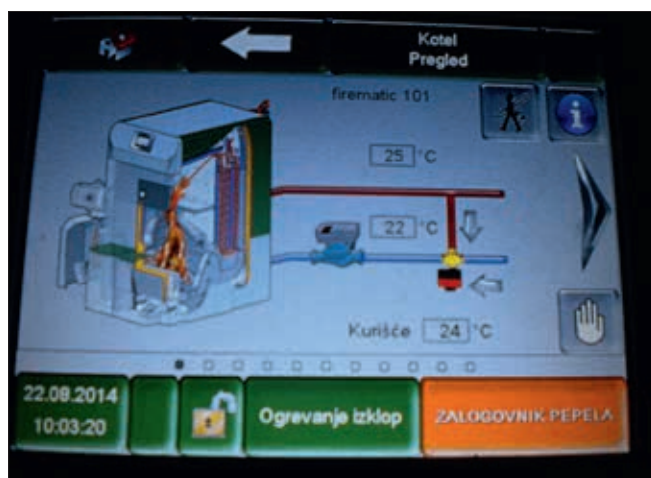
Slika 5: Regulacijska enota z barvnim zaslonom na dotik in menijem v slovenskem jeziku
