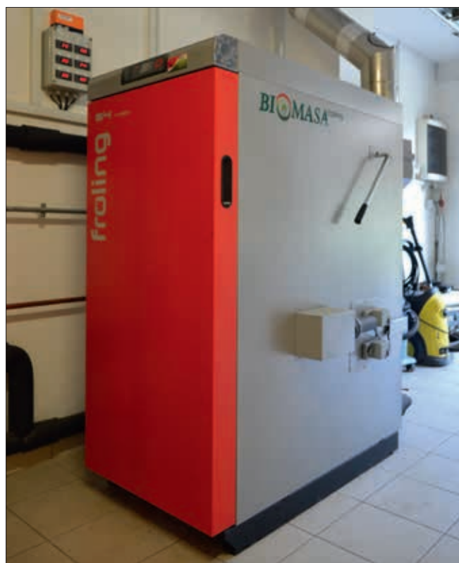
Kotel na polena Fröling S4 z avtomatskim vžigom
