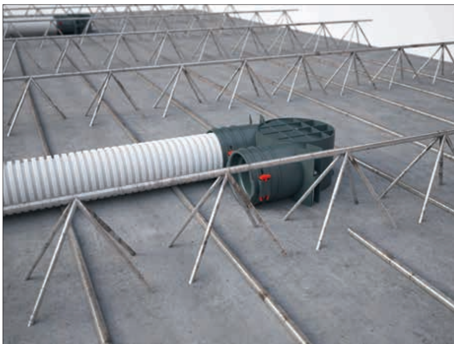
Slika 1, polaganje FRS periferije med armaturo AB plošče.
