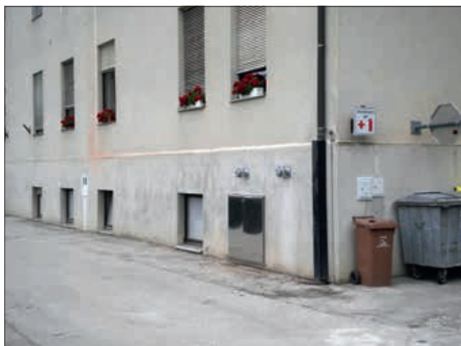
Slika 1: Vrata skladišča za pelete v OŠ Krmelj
