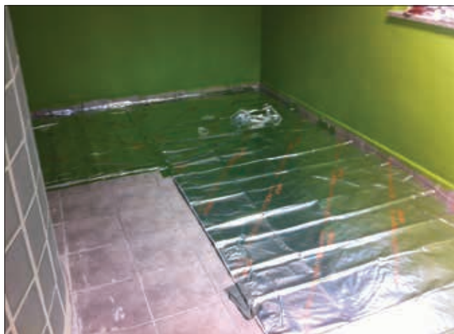
Polaganje talne izolacije direktno na obstoječe ploščice
