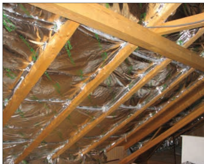
Polaganje izolacijske folije med škarnike, tako da so ti po podeskanju vidni
