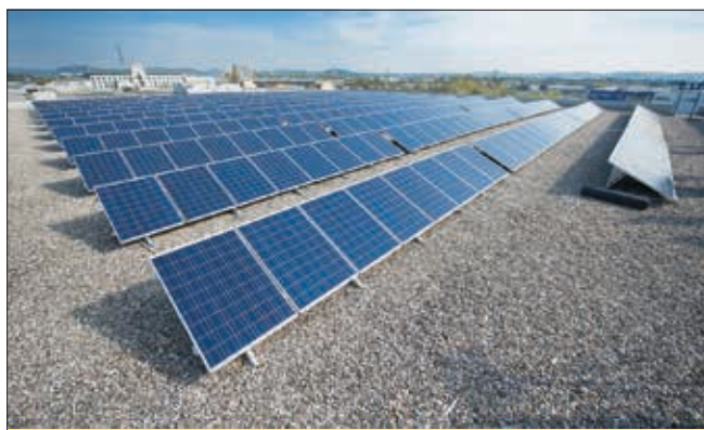
Streha salona Rutar v Mariboru z 907 sončnimi paneli, ki letno proizvedejo 230.000 kWh
