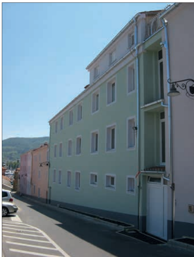
Severna fasada kompleksa pred in po energetske sanaciji. Materiali, barve in detajli so bili izbrani skladno s kulturno- varstvenimi pogoji Zavoda za kulturno dediščino Slovenije, saj je kompleks v območju spomenika Izola – Mestno jedro.
