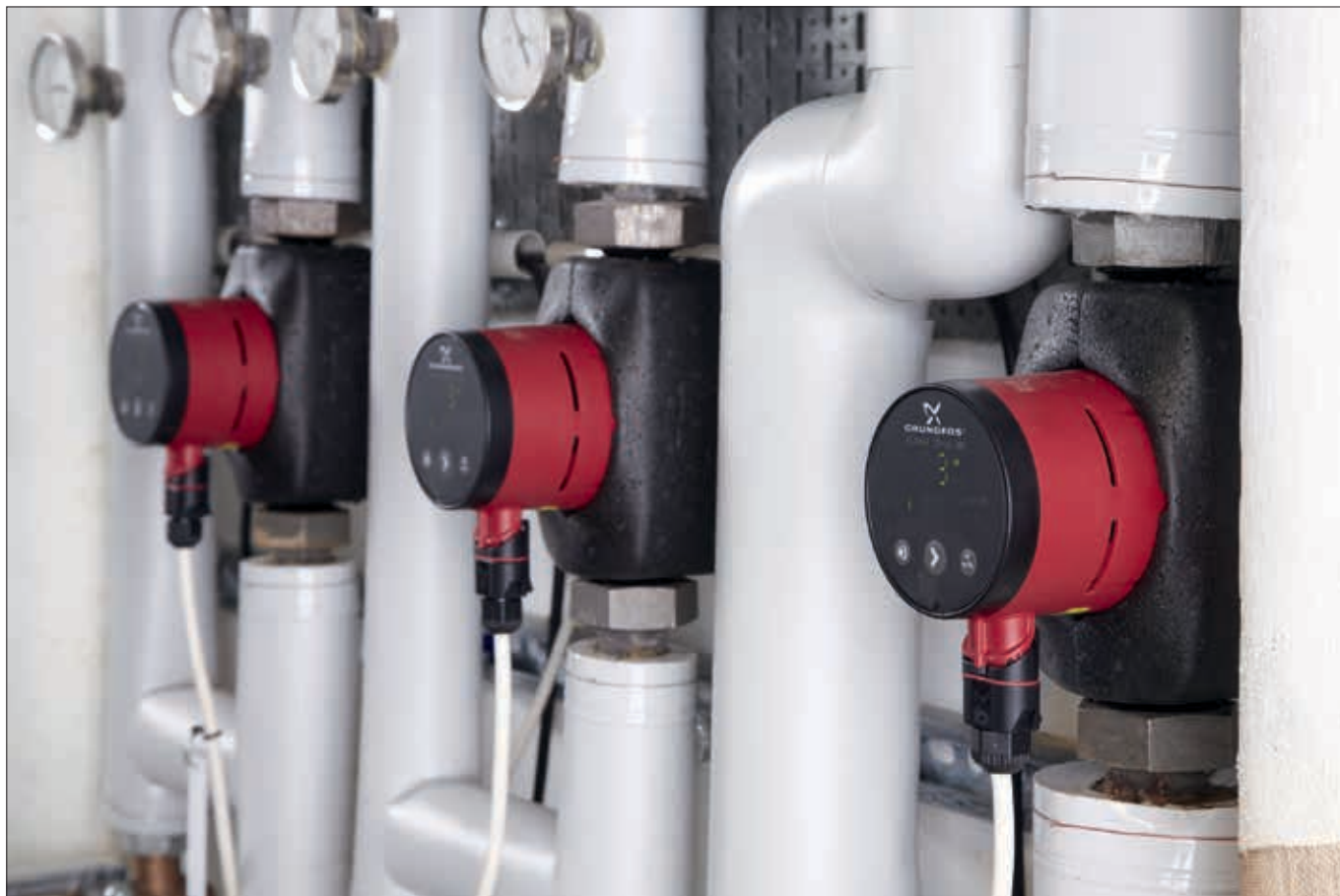
Nova generacija črpalk Alpha2, vgrajenih v bolnišnici
