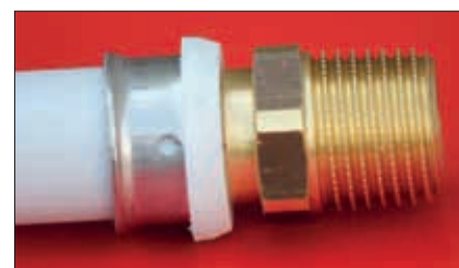
spojimo cev in fitting – vizualna kontrola
