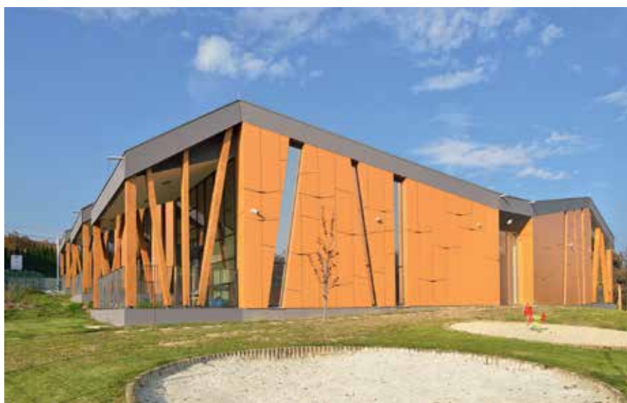
Širok spekter oblikovalskih možnosti dopolnjujejo še površinsko obdelane plošče s perforacijami in 3D ornamenti, ki dajejo objektu dodaten poseben pečat.
