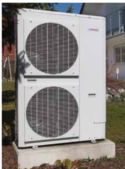
Slika 2: Zunanja enota na vrtu
