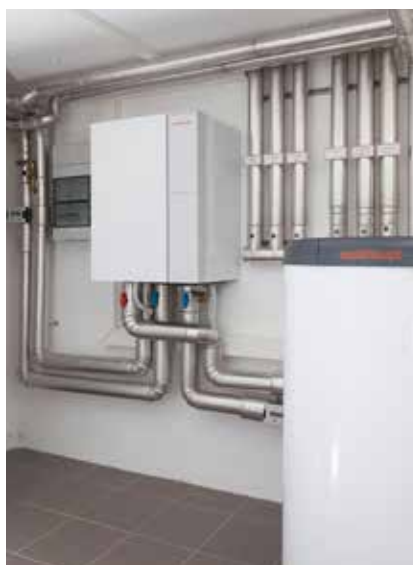
Slika 3: Notranja enota in hranilnik STV v kleti
