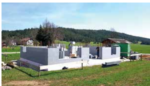
Sestavljanje elementov JUBHome WALL
