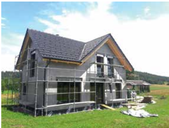
Vgradnja stavbnega pohištva
