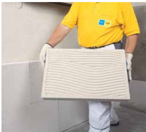
Toplotna izolacija stropa – do debeline 140 mm sidranje ni potrebno.
