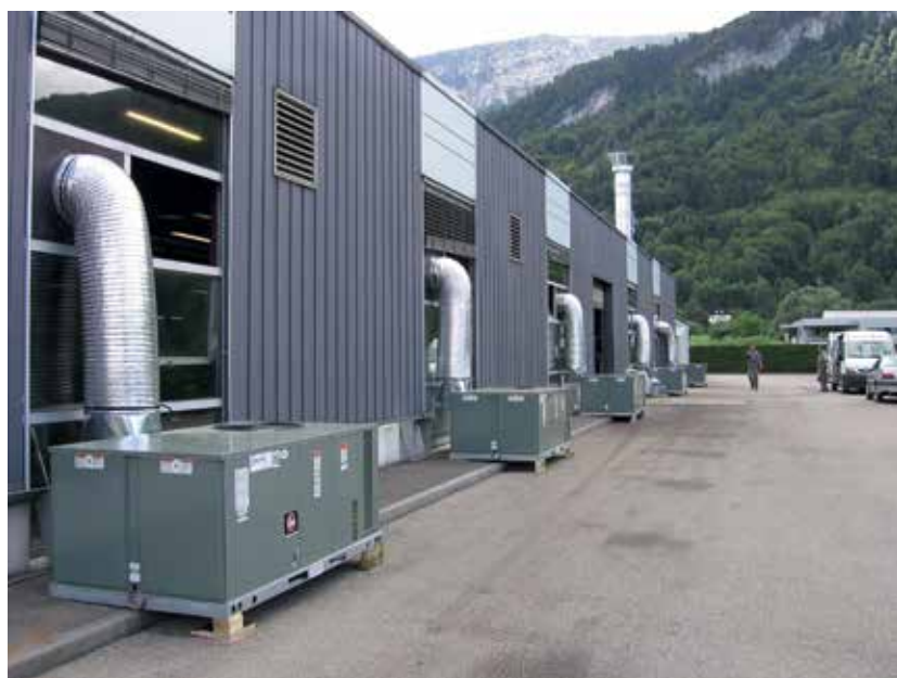
Zunanja postavitve hladilno grelnih enot KlimaRent®.
