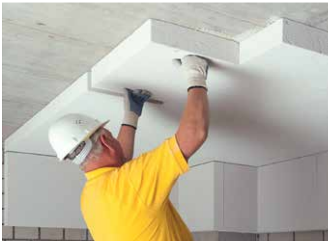
Toplotna izolacija stropa – do debeline 140 mm sidranje ni potrebno.
