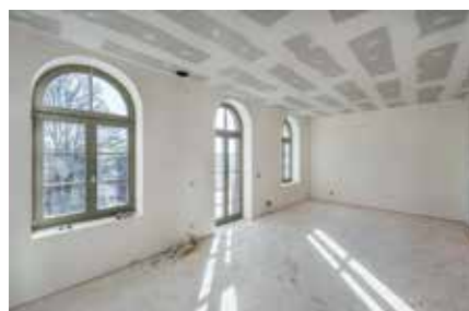
Kapilarno aktivna notranja izolacija Multipor ne potrebuje parne zapore.
