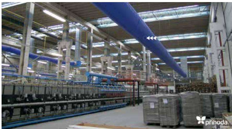
Notranja postavitve tekstilnih kanalov Prihoda®
