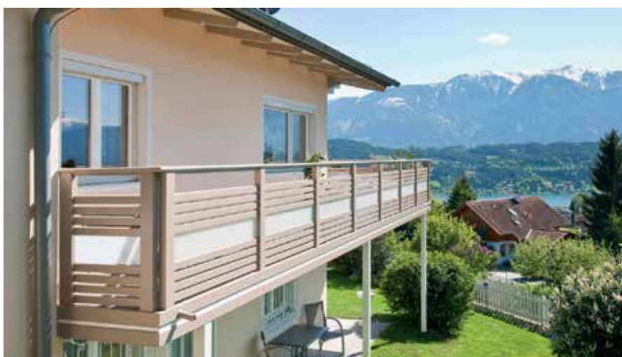
Balkonska konstrukcija na stebrih
