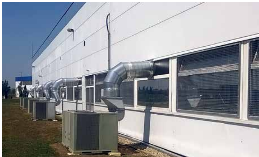
Zunanja postavitev hladilno grelnih enot KlimaRent®
