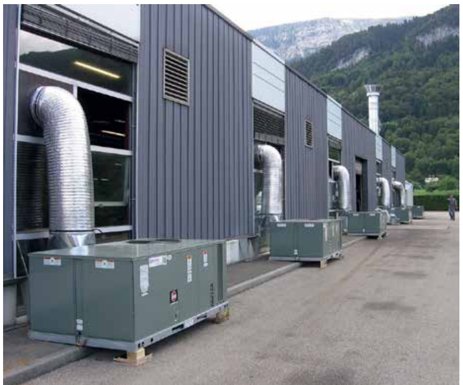
Zunanja postavitev hladilno grelnih enot KlimaRent®
