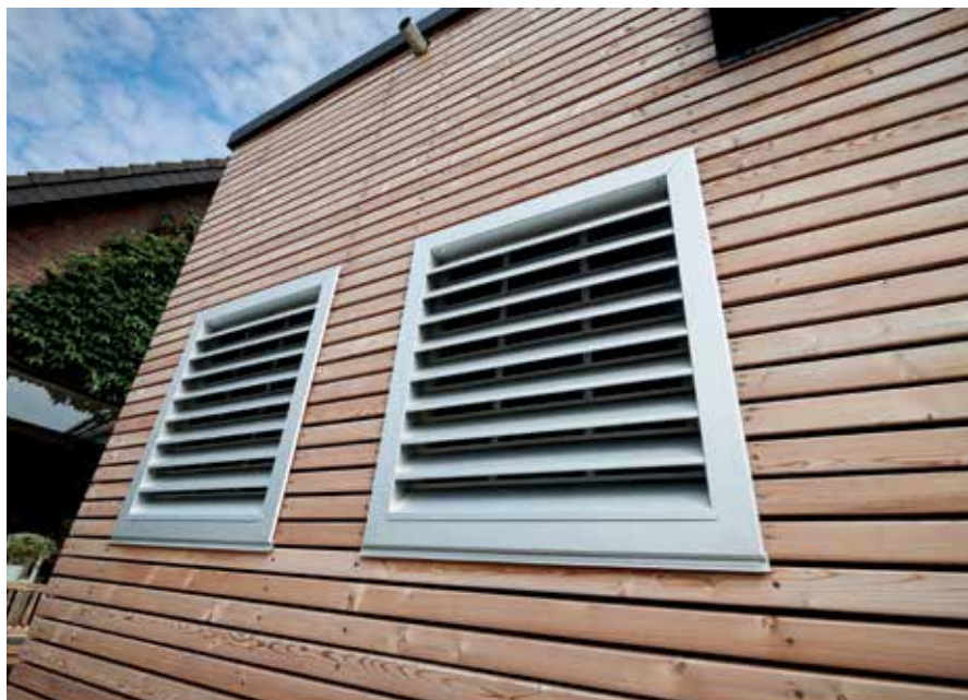
Edino kar je vidno zunaj, so rešetke za dovod in odvod zraka
