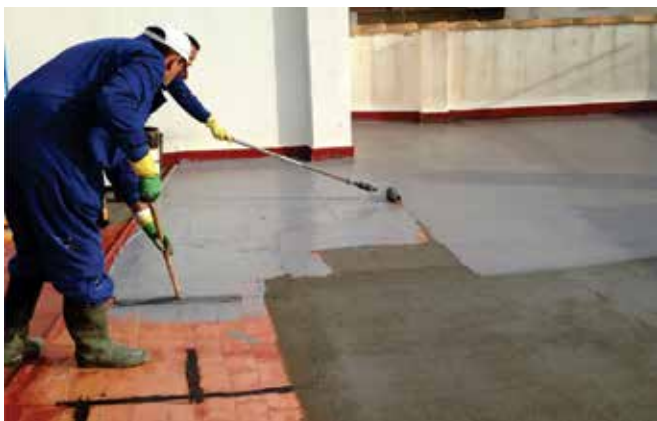
Nanos brezšivne elastične hidroizolacijske membrane
