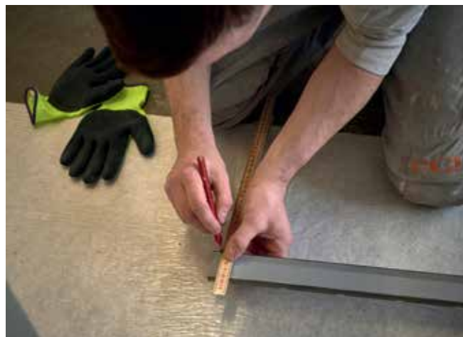
Pršne kanalete Geberit CleanLine80 so na voljo v standardnih dolžinah 90 cm in 130 cm ter se ob vgradnji z ročnimi orodji (ne brusilko) preprosto odrežejo do natančno zelene površine.
