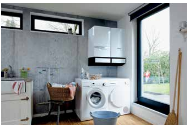
Plinski kondenzacijski kotel ecoTEC VU in stenski vsebnik STV uniSTOR
