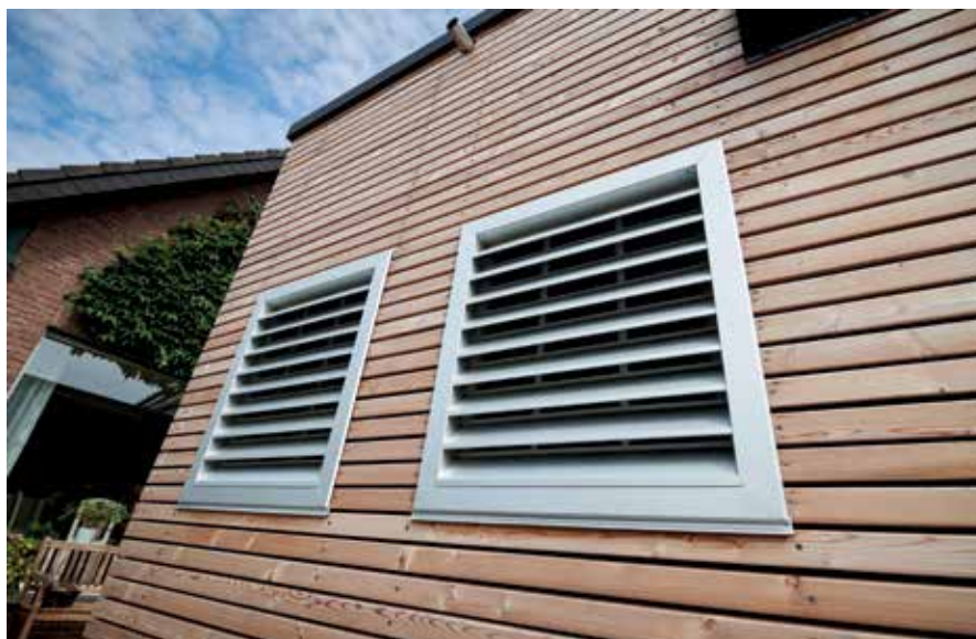
Edino kar je vidno zunaj, so rešetke za dovod in odvod zraka
