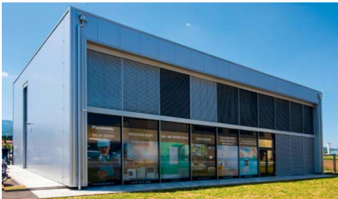
Stavba učnega centra Panasonic v Hočah
