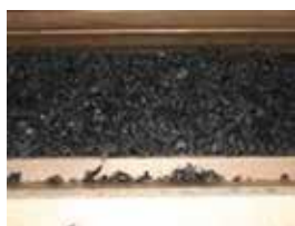
Prikaz vpihane izolacije Fonaterm med stene v mansardi.
